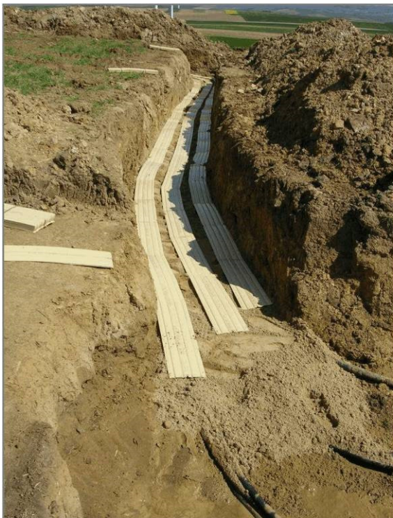
Verlegung durch Graben einer Künette
