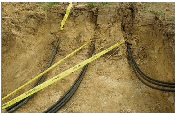
Übergang Pflugverlegung - Künette
