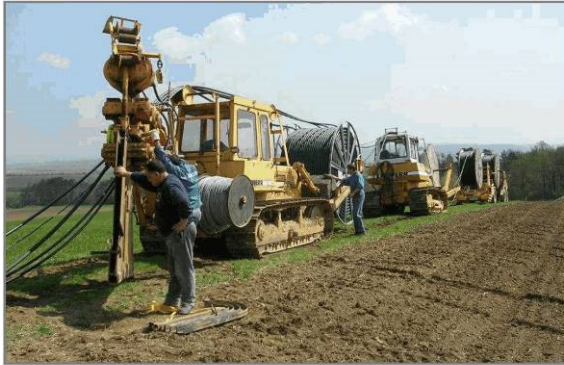
Pflug-Tross: Verpflügung direkt von den Kabeltrommeln
